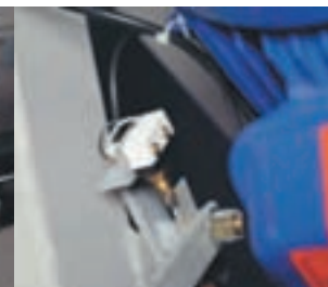
Блокировка приводной цепи эскалатора
