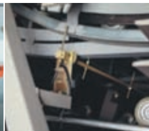
Выключатель безопасности, срабатывающий при поломке ступеней
